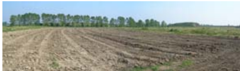
Vista di una porzione del lotto A dopo realizzazione delle trincee drenanti (area priva di copertura erbosa)
