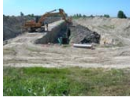
Lavori di scavo della trincea drenante e installazione del pozzo percolato
