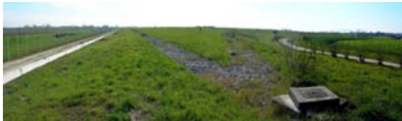
Vista da ovest verso est del corpo di discarica dei lotti B+C
