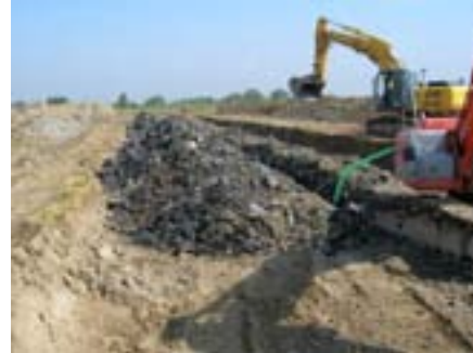
Lavori di scavo della trincea drenante e posizionamento del tubo di drenaggio del percolato (tubo verde nella foto)
