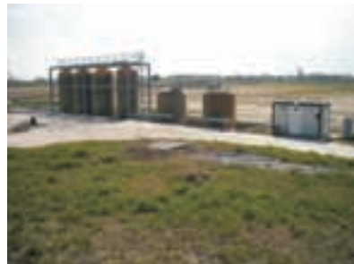
Vista delle cisterne di raccolta del percolato dei lotti A e B+C.
