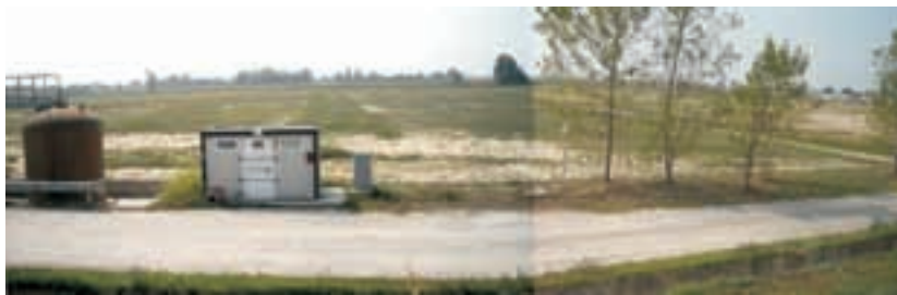
Vista di una porzione del lotto A dopo regolarizzazione del terreno superficiale
