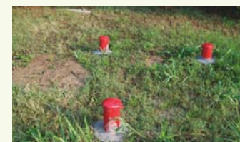
Nuovi piezometri della Tripletta 1 terebrati in prossimità dei precedenti, che risultavano danneggiati
