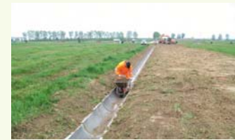
Fasi di realizzazione delle canalette di scolo del settore A.2. - nord
