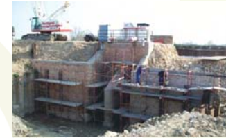
Lavori di sistemazione della chiavica posizionata nei pressi dell'ingresso alla discarica, a nord-est
