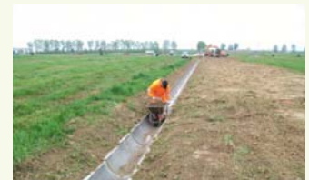
Fasi di realizzazione delle canalette di scolo del settore A.2. - nord
