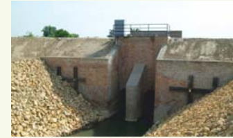
Conclusione dei lavori di sistemazione della chiavica posizionata nei pressi dell'ingresso alla discarica, a nord-est
