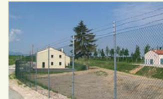
Recinzione realizzata lungo il lato nord, nei pressi del cancello di ingresso
