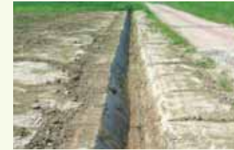
Manutenzione delle canalette di scolo delle acque meteoriche sul lotto A
