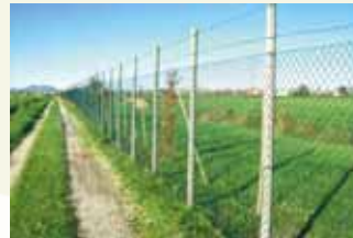
Recinzione lungo il lato nord della discarica
