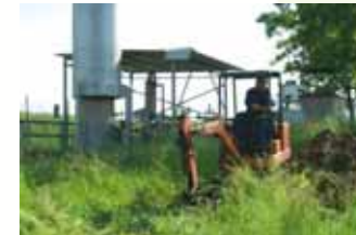
Lavori di ricerca di un guasto della condotta idrica
